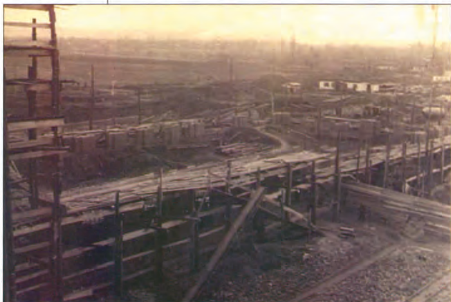
Возведение стен сахарозавода. 1949 г. Государственный музей истории Александровского района.
